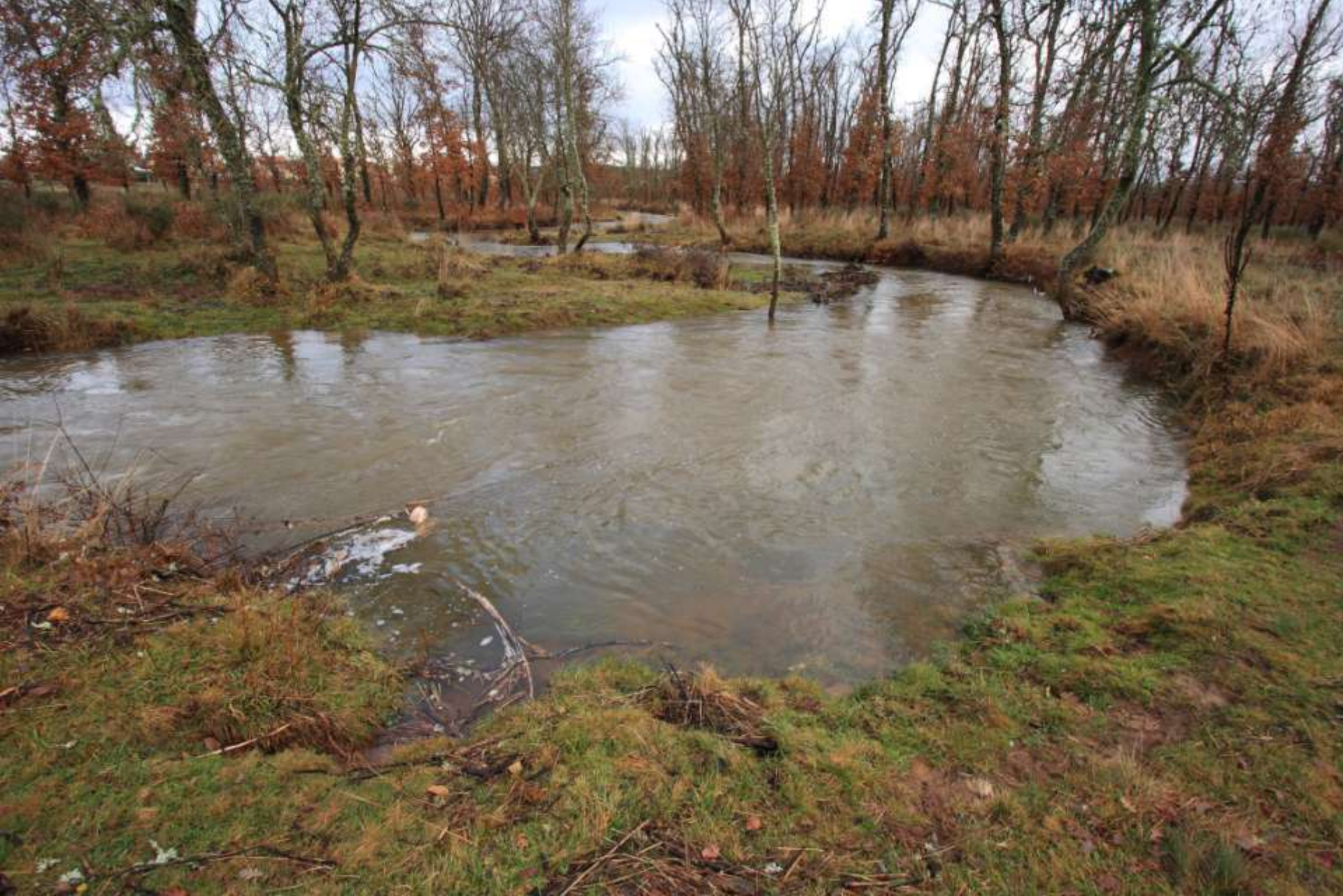
Castrón river, Ferreras de Abajo (Zamora-Spain) Bankfull stage after works
