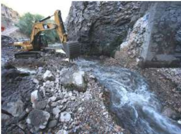
Retirada de escombros
