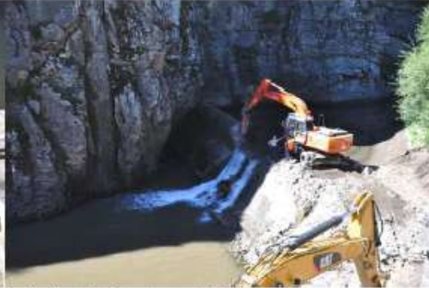
Inicio de la demolición del muro
