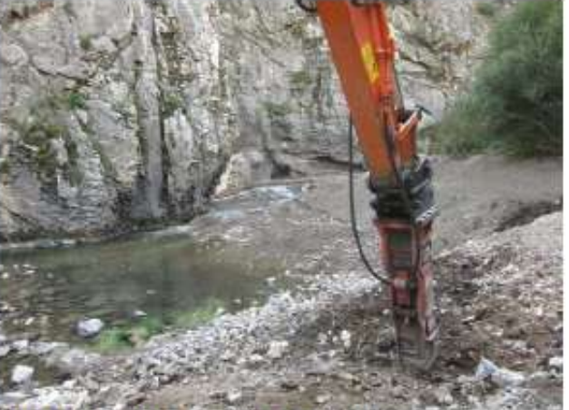
Finalización de los trabajos
