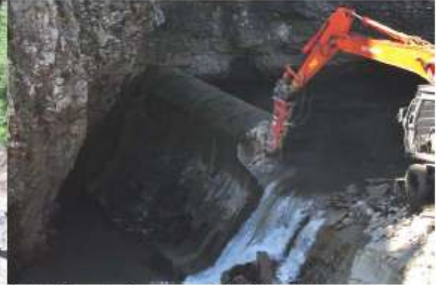
Detalle de la demolición del muro
