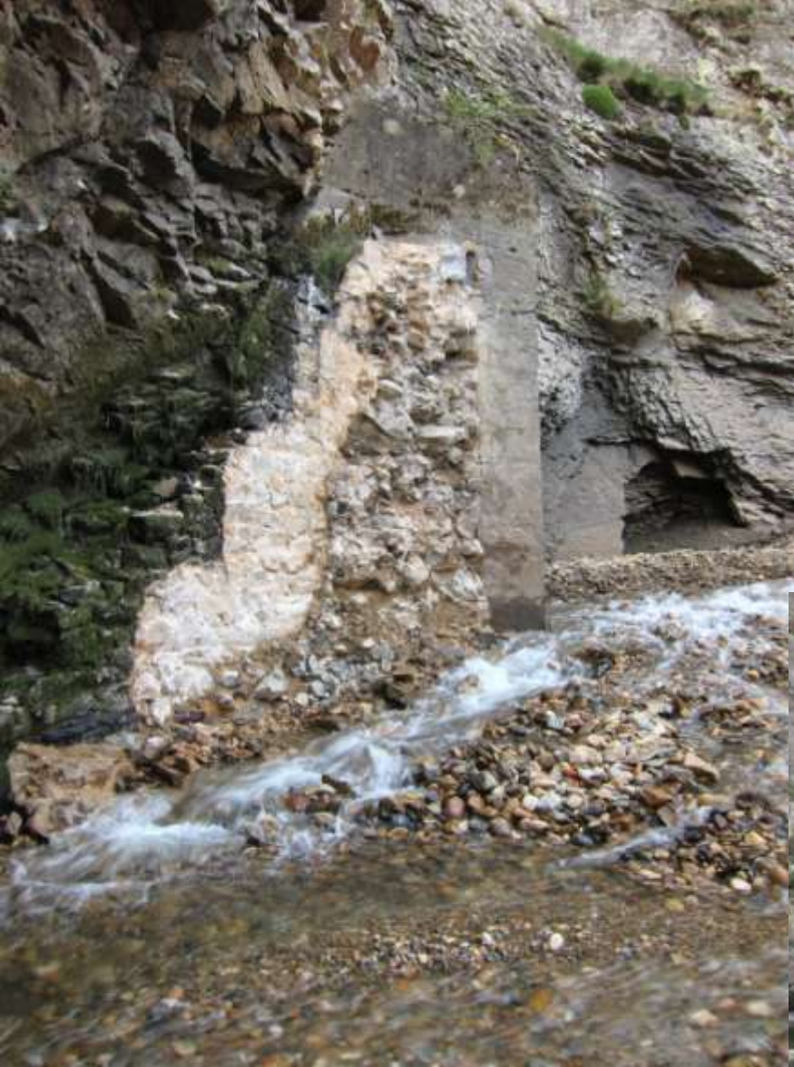
Demolition fo the La Gotera weir (Bernesga river, León-Spain)
